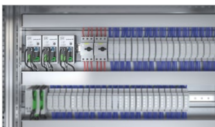
Dank der kompakten Bauform können die IFD2411 Controller einfach in Schaltschränke integriert werden.
